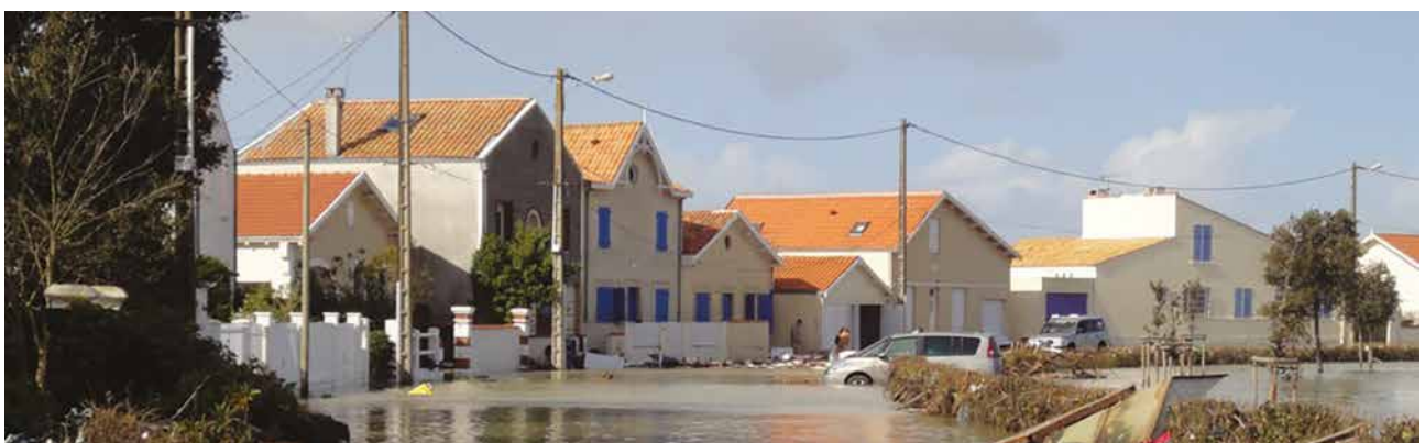
📍 Rue du bois vert, Fouras (France) après le passage de la tempête Xynthia. © Julien Prineau, 28 février 2010.
